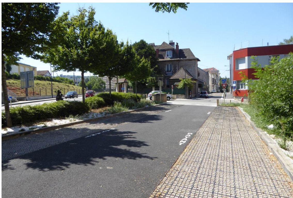
Fig. 30. Exemple paviment drenant en calçada a la ciutat de Besançon
