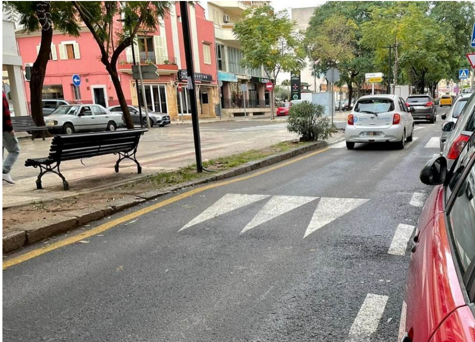
Fig. 54. Reductors de velocitat a Gran Via Colom Font: Elaboració pròpia
