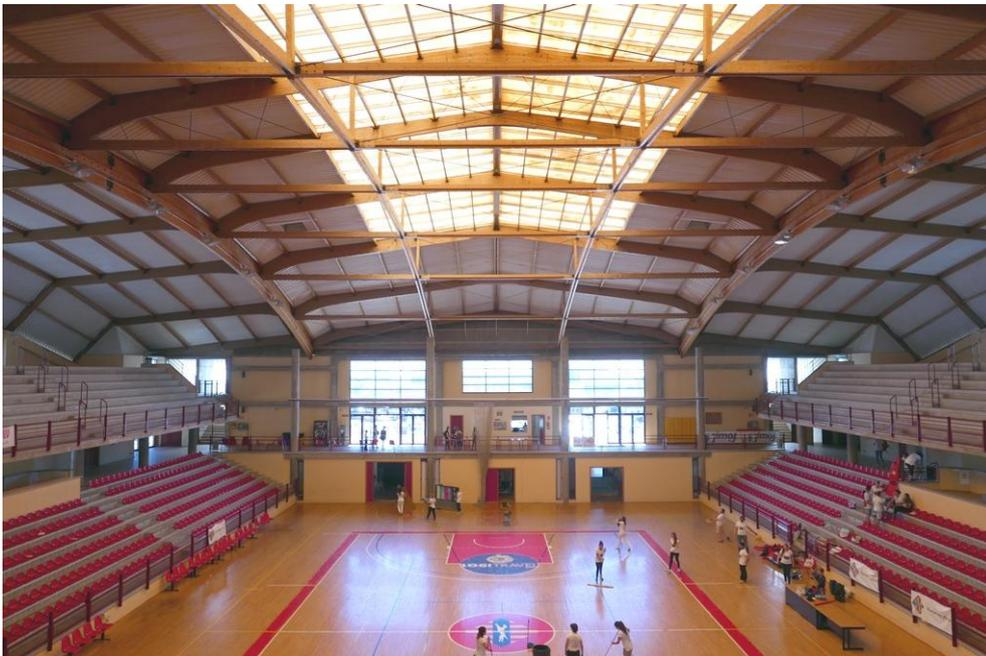
En la imagen anterior se aprecia la existencia de un gran lucernario sobre la pista central, realizado con paneles translúcidos.
