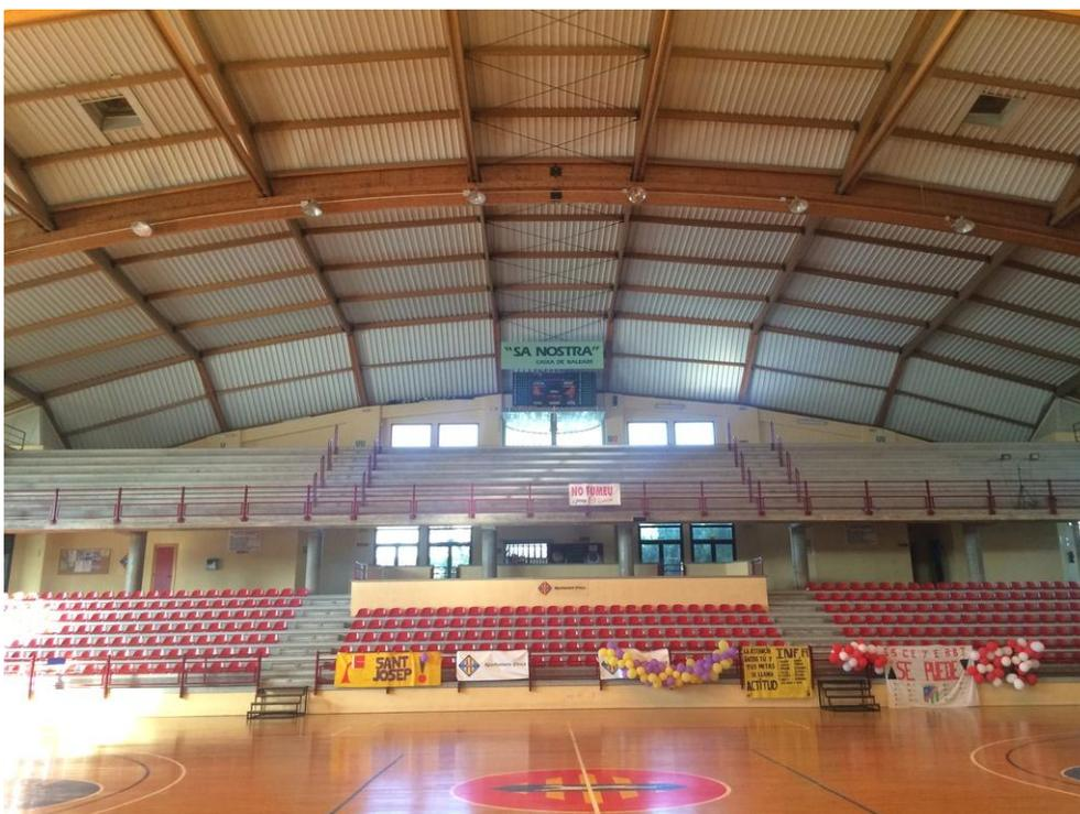
Los dos arcos de madera principales sirven a su vez de soporte a ocho cerchas a base de barras de madera encolada con un vano central de 27,30 m y dos vanos laterales de 13,90 m:
